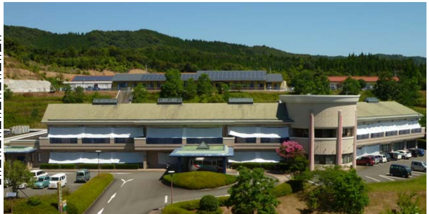
福祉生活ゾーン「ひだまりの里」の中にある新和病院。敷地内には各福祉厚生施設が集積している
